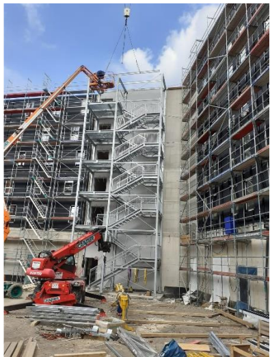
Figura 6 - Realizzazione passerella
