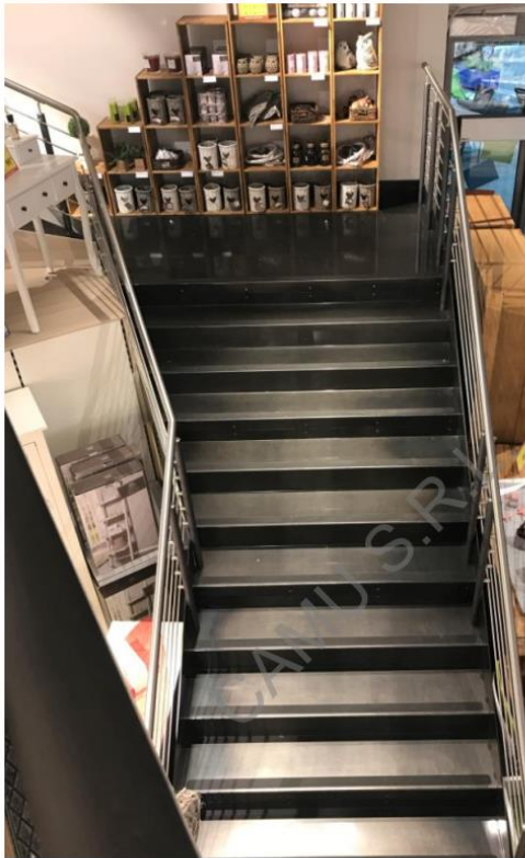
Figura 11 - Realizzazione scala in acciaio
